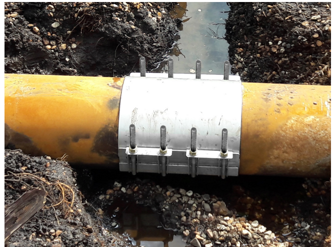
Nach der Reparatur
